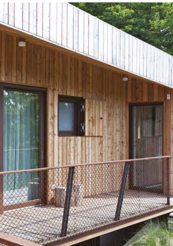
Installazione rivelatori in esterno
